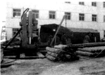
图 3 晋城寺河煤矿小东山风井反井钻井施工现场
